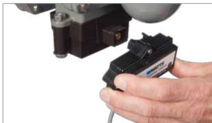
2. Presione el módulo de activación sobre el sensor.
